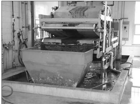
شکل ۲- دستگاه فیلترپرس برای آگیری جامدات زیستی
